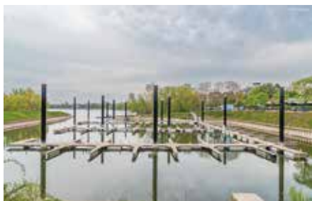
Fertige Steeganlage - Foto: Wilms
