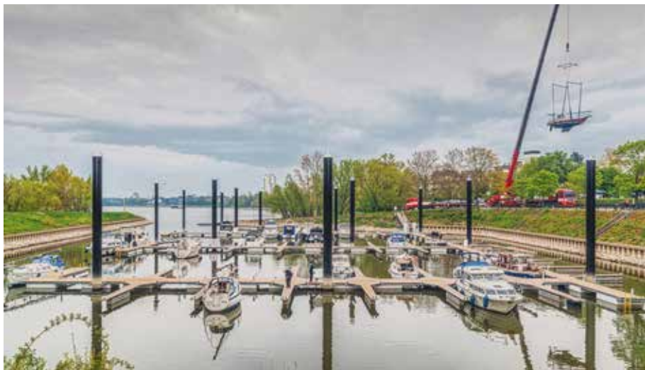
Einkranen der Boote - Foto: Wilms
